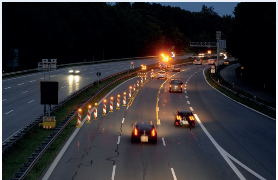
Bild 1: Fahrstreifen zur Weiche gesperrt. Während der verkehrsarmen Zeit wird eine 4+0-Verkehrsführung mit einer Geschwindigkeit von 80 km/h betrieben. Dazu ist der jeweilige 3. Fahrstreifen mit einem konventionellen Fahrstreifeneinzug mit beleuchteten Baken eingezogen. Zusätzlich wird der Fahrstreifen mit einer mobilen Absperrschranke und einem gelben Blinkpfeil gesperrt
