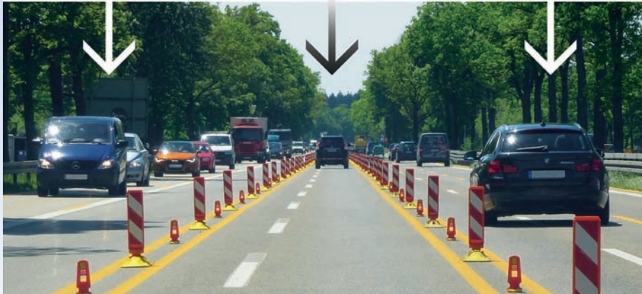
Bild 7: Wechselerkehrsführung unter Verkehr
