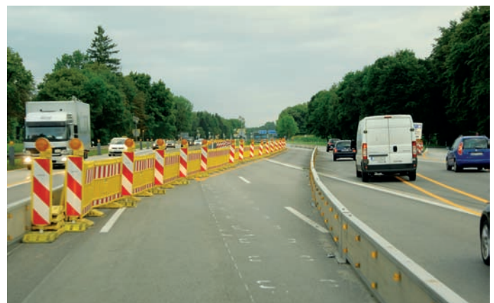
Bild 6: Ausfahrt aus der Weiche(Süd) über MÜ in Richtungsfahrbahn Der Verkehrsteilnehmer durchfährt diese Weiche (Bakern und Zaun verhindern auch hier das „Falschfahren“) und wird über die MÜ auf die ursprüngliche Richtungsfahrbahn übergeleitet
