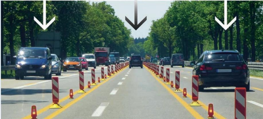
Bild 7: Wechselerkehrsführung unter Verkehr
