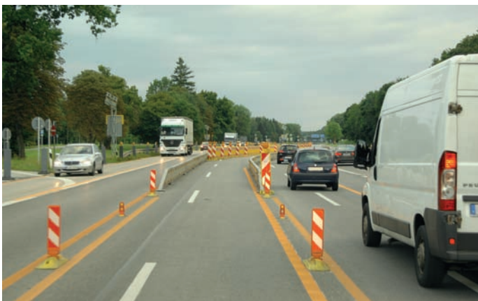
Bild 5: Weiche (Süd) in FR GAP geöffnet zur Ausfahrt aus dem Wechselfahrstreifen. Die Ausfahrt des Wechselfahrstreifens im Bereich der 2. Mittelstreifen-überfahrt wird wie bei der Einfahrt mit transportablen Schutzeinrichtungen im Bereich der Weiche abgegrenzt
