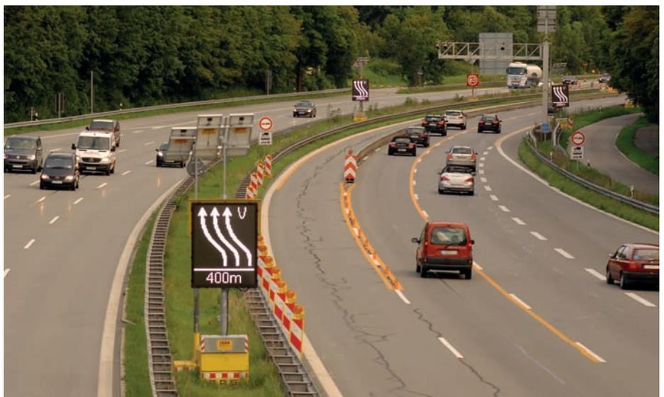
Bild 2: **Fahrstreifen zur Weiche geöffnet.** In der Spitzenstunde wird für die erforderliche Fahrtrichtung der Fahrstreifeneinzug aufgehoben. Die Leitbaken werden an den Fahrbahnrand gezogen und die Absperrschranke und der Blinkpfeil abgebaut. Somit steht der 3. Fahrstreifen für diese Fahrtrichtung zur Verfügung. Zur Abgrenzung der Fahrstreifen wurden im Einfahrbereich transportable Schutzzeine aufgestellt
